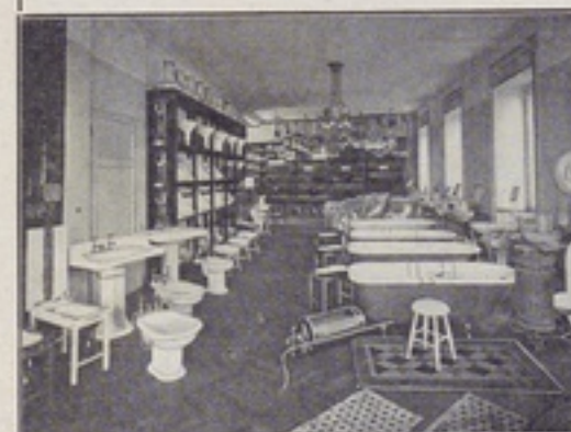
Veduta di una parte dei Magazzini superiori
