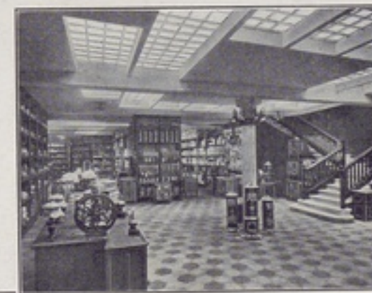
Veduta di una parte dei Magazzini sotterranei
