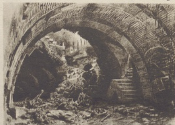
LO SPOLIARIUM DOPO IL CROLLO
