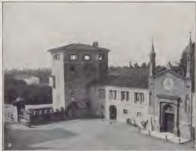
UN LATO DEL CORTILE D'ONORE CON LA FACCIATA DELL'ORATORIO.
