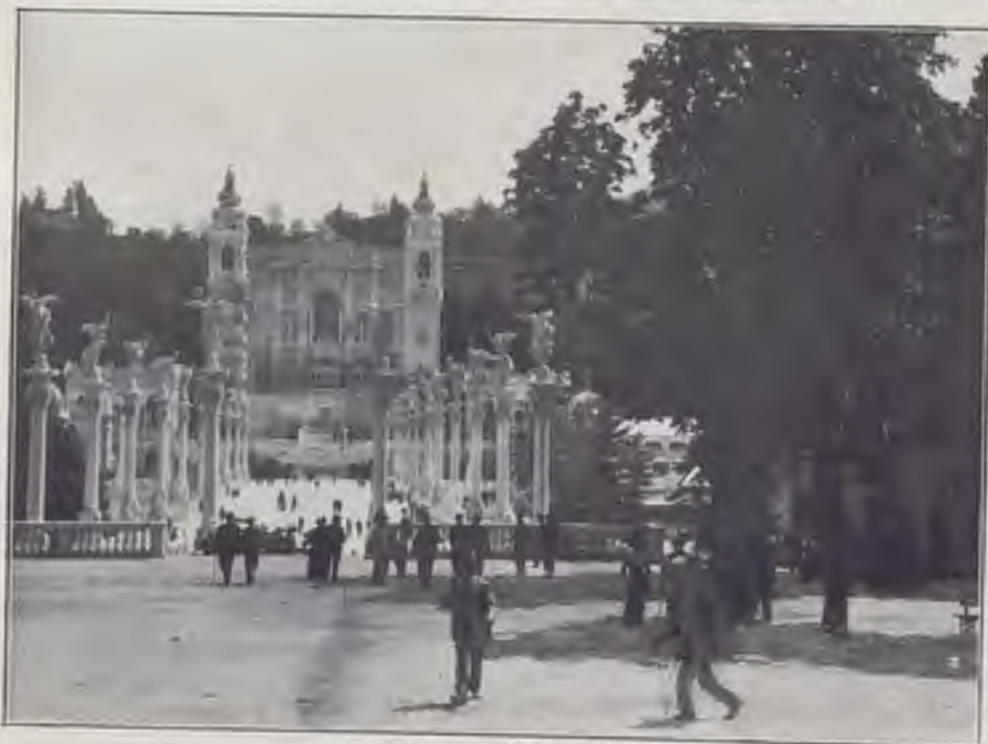
PONTE E FONTANA MONUMENTALI.
