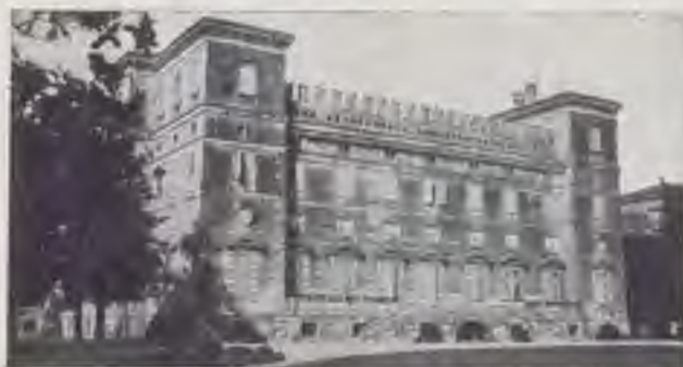
FACCIATA VERSO LEVANTE.
