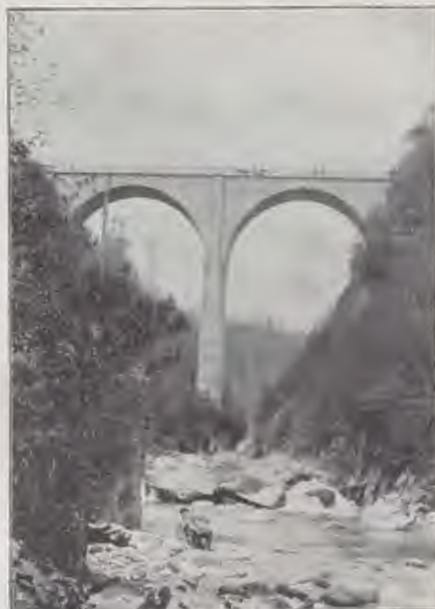
PONTE DI BORGEGOLO.
