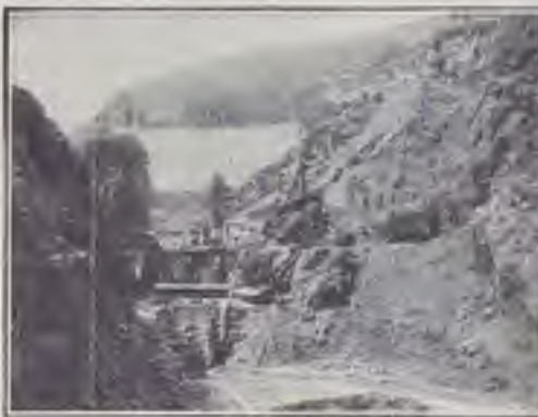
MALPIDANO - LA MINIERA A CIELO APERTO, VISTA DAL FONDO.
