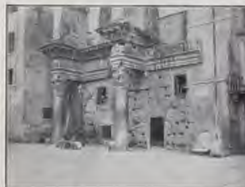
FORO DI NERVA, ANCH'ESSO ABITATO. NELLA PRIMA FINESTRA SI VEDE UN VASO DI PIOMBO, NELLA SECONDA LA GABBIA DI UN CANARINO.
