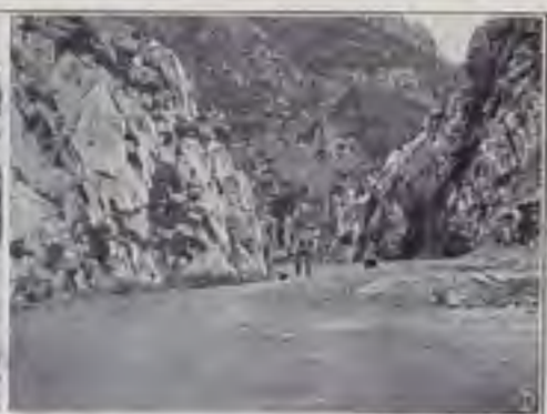
SALISRUSSA - LAVORAZIONE A CIELO APERTO.
