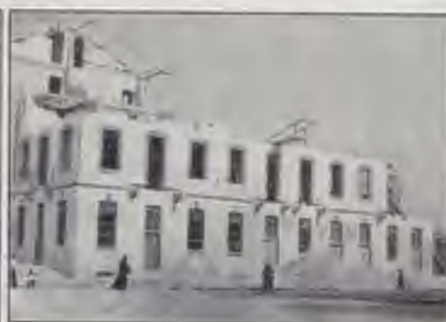
UN ANGOLO IN DEMOLIZIONE
