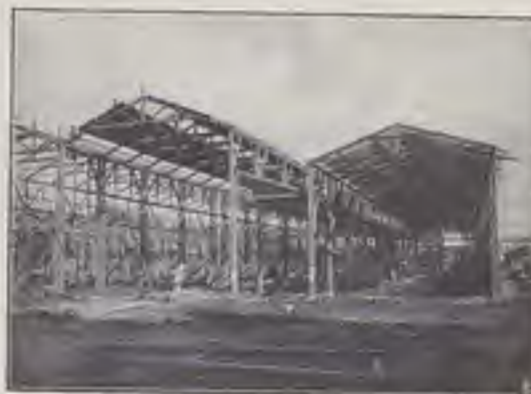
Le grandi Gallerie in costruzione della «Mostra ferroviaria».
