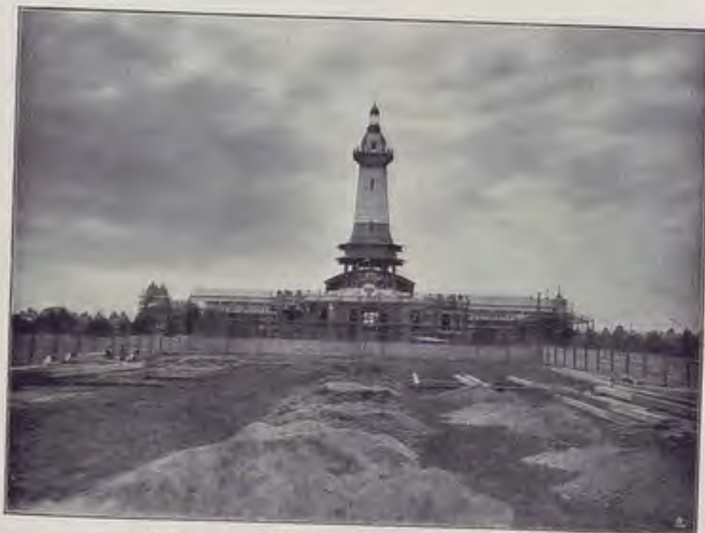
** Lo stato attuale dei lavori della «Galleria di Marina e del Faro».
