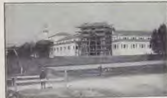
Una fianca della «Galleria del Lavoro». Stato attuale dei lavori.
