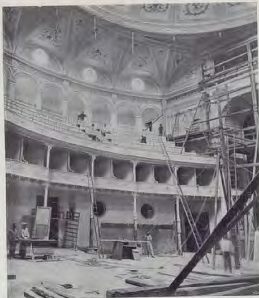
TEATRO DAL VERME - Dettaglio fianco sinistro.
