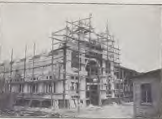
Il «Palazzo della Circoscrizione». Stato attuale dei lavori.
