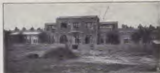
Lo stato attuale dei lavori della «Caserna dei Pompieri».
