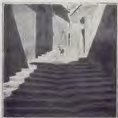
4. - Vieux Marseille: Una rampa.
