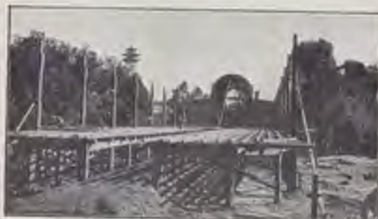
** Stazio attuale dei lavori della «Stazione di portento» al Parco.
