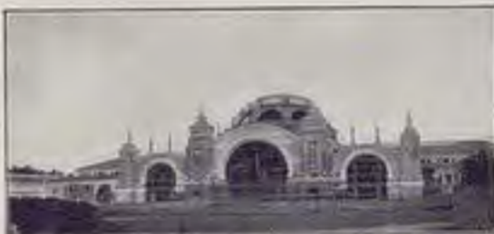
** Facciata principale della «Galleria del Lavoro». Stato attuale dei lavori.
