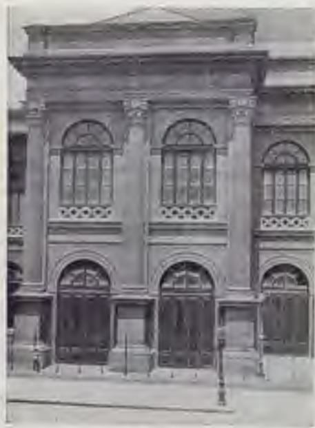
Particolare di un prospetto laterale.
