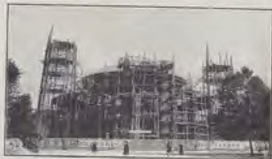
** Il grande Salone dei festeggiamenti in costruzione.
