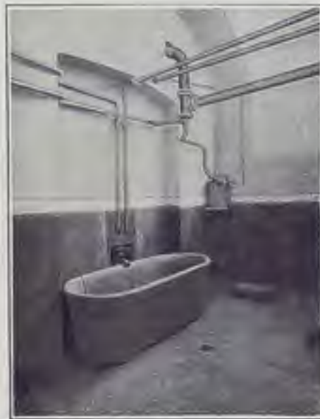
Gabinetto da bagno con doccia.
