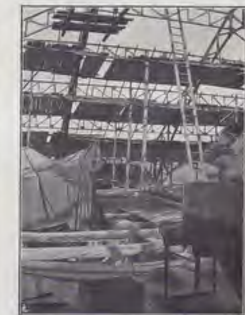
6. — Travature della nuova sala.
