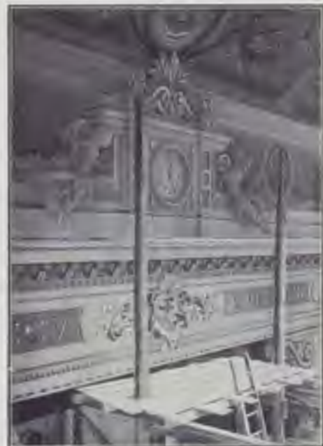
Fot. Ulderico David. Fronte della nuova bocca d'opera.
